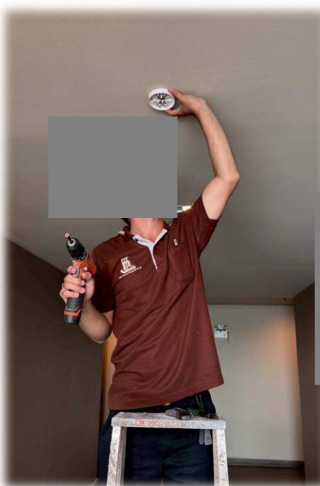
เปลี่ยนอุปกรณ์ตรวจจับควันไฟที่ เสื่อมสภาพ ของชั้นพักอาศัย
