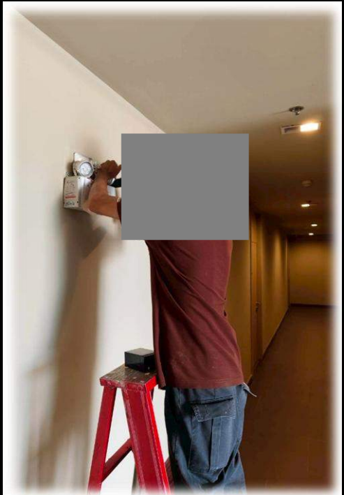
เปลี่ยนแบตเตอรี่ของไฟฉุกเฉินบริเวณโถงทางเดิน ชั้น 15
