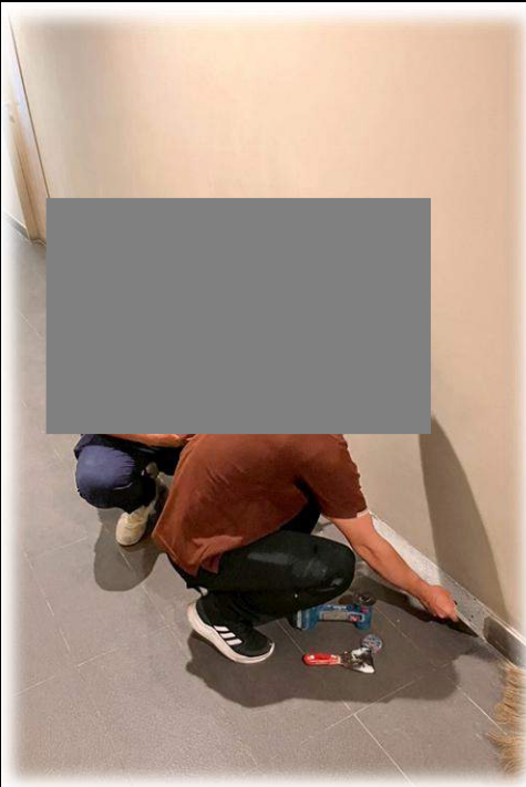
ซ่อมแซมขอบบัว บริเวณทางเดิน ชั้น พักอาศัย ชั้น 7 และ ชั้น 12A
