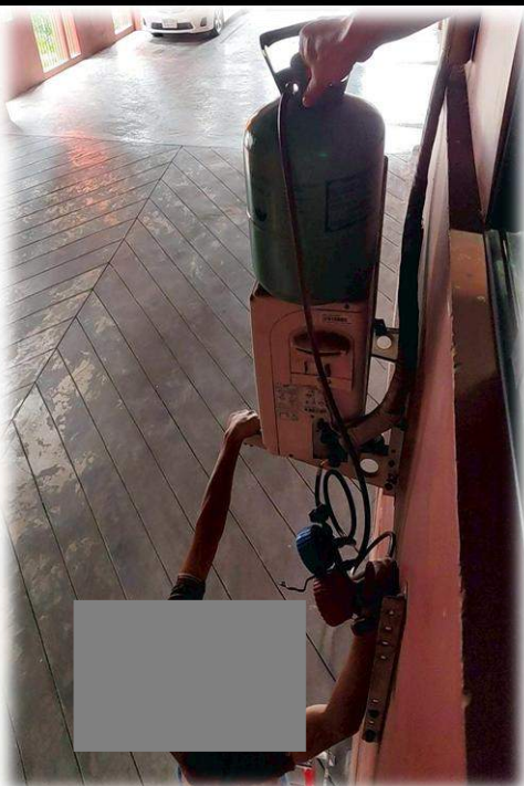
เติมสารทำความเย็นระบบปรับอากาศ ห้องประชุม ชั้น P4
