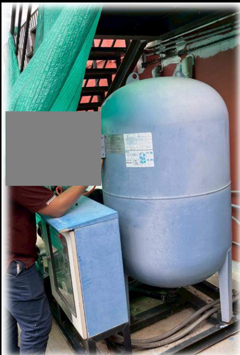
เติมลมเครื่องบดสโตรปีม (ระบบเพิ่ม แรงดันน้ำประปาอาคาร)
