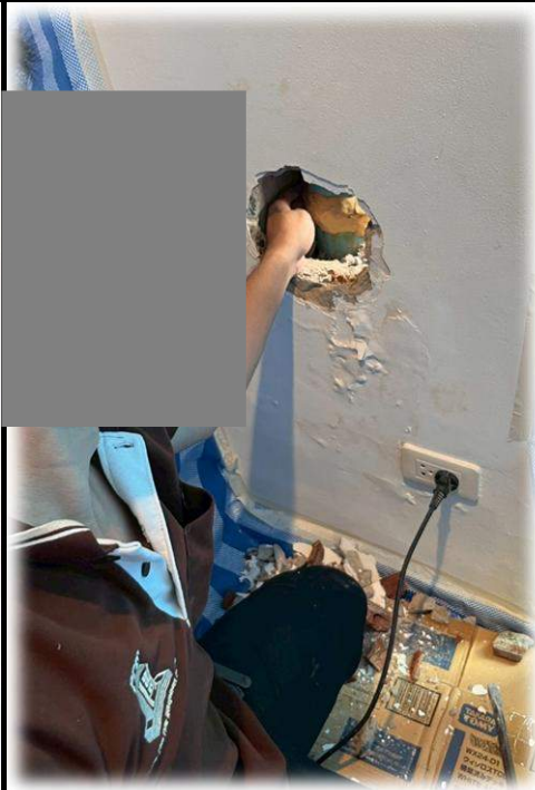
ตรวจเช็คท่อระบายน้ำรั่วซึมหลังผนัง ห้องชุด 8/203
