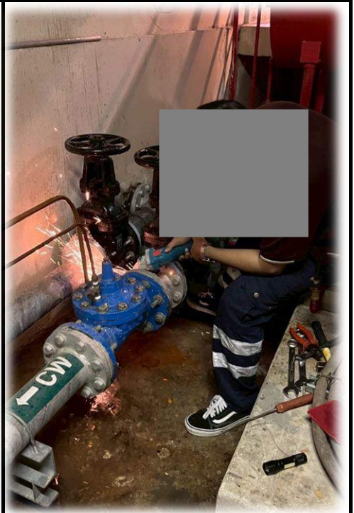
ซ่อมแซมระบบท่ส่งน้ำสู่เครื่องบีบ น้ำประปาของอาคารชุด ชั้น G
