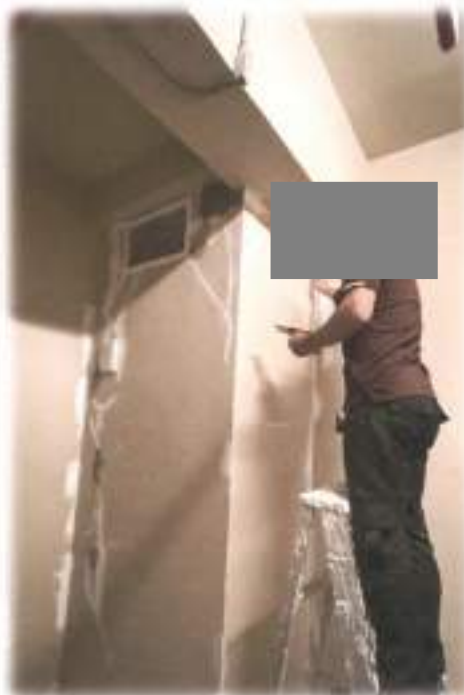
ซ่อมแซมรอยร้าวผนังโถงลิฟท์เซอร์วิส ชั้น G - 23
