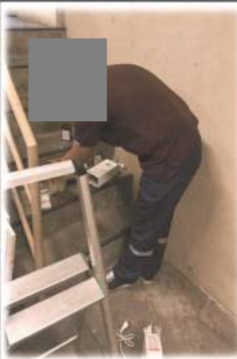
เปลี่ยนแบตเตอรี่ไฟส่องสว่างฉุกเฉิน ของห้องควบคุมระบบไฟฟ้าหลัก ของ อาคารชุดชั้น G
