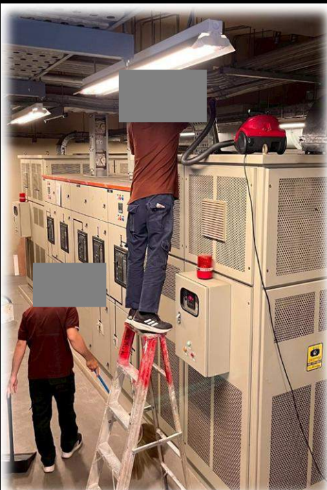
ทำความสะอาดและบำรุงรักษาระบบ MDB (ห้องควบคุมระบบไฟฟ้าหลัก)
