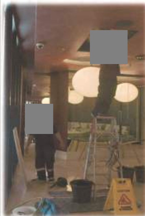
แก้ไขทากน้ำทิ้งเครื่องปรับอากาศชุดต้น บริเวณโถงรับรองชั้น G
