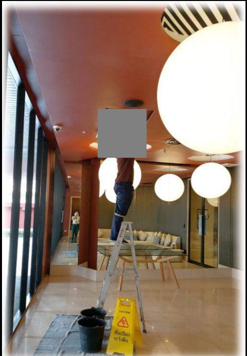
งานแก้ไขปัญหาน้ำหยดจากเครื่องปรับอากาศบริเวณลิโอบบี้ ชั้น G
