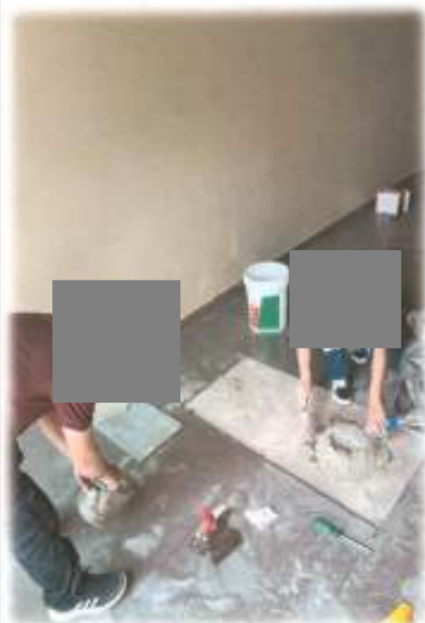
ซ่อมแซมพื้นกระเบื้องชำรุดโถงทางเดิน ส่วนกลางชั้น 21
